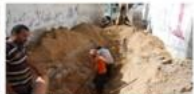
إنشاء شبكة صرف صحي في الزيتون
