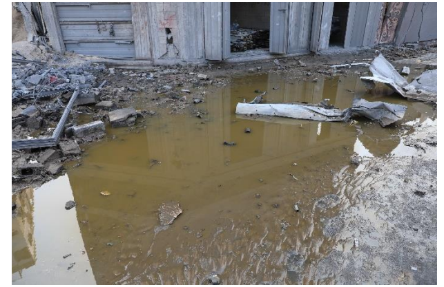
المياه العادمة نتيجة تدمير البنية التحتية لشبكة الصرف الصحي
