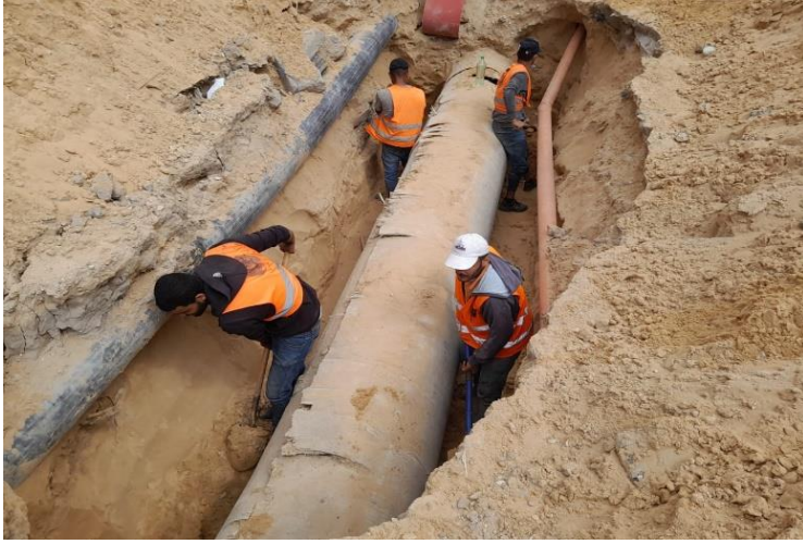
موظفو بلدية غزة أثناء قيامهم بعمل صيانة لخطوط الصرف الصحي
