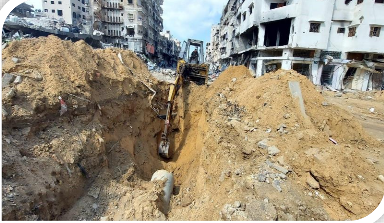
موظفو بلدية غزة أثناء قيامهم بعمل صيانة لخطوط الصرف الصحي
