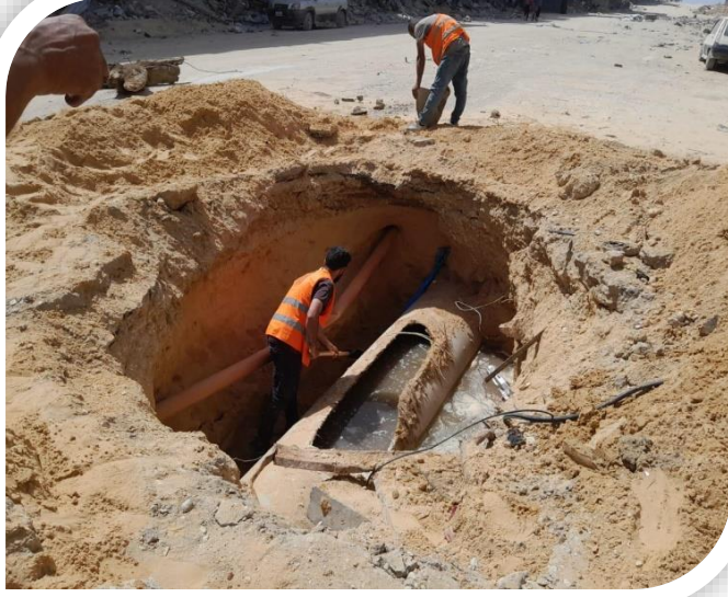
موظفو بلدية غزة أثناء قيامهم بعمل صيانة لخطوط الصرف الصحي
