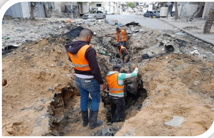
موظفو بلدية غزة أثناء قيامهم بعمل صيانة لخطوط الصرف الصحي
