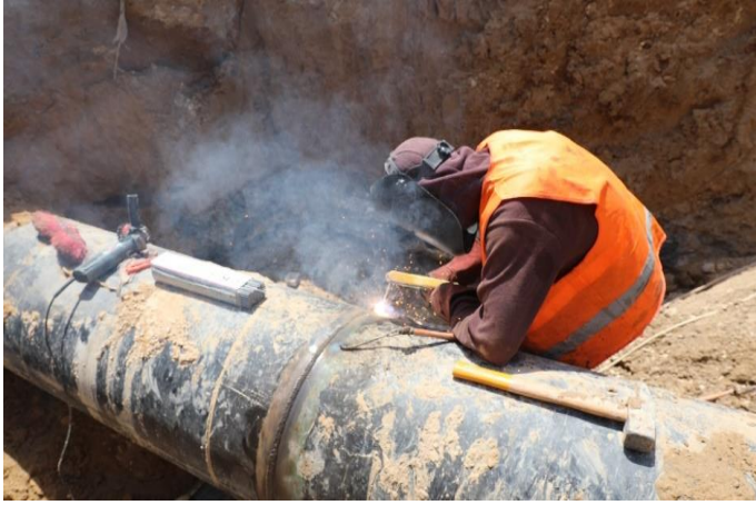
أحد طواقم البلدية أثناء صيانة أحد خطوط المياه المتضررة
